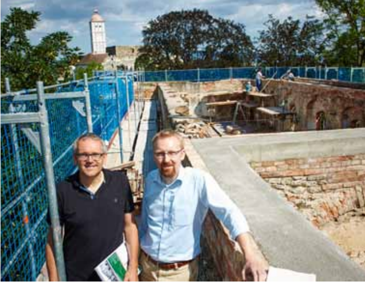
Schallaburg-Geschäftsführer Kurt Farasin (l.) und Schallaburg-Standortleiter Peter Fritz auf der Baustelle am 1570 erbauten Neuschloss. Foto: Stadt Melk / Gleiß
