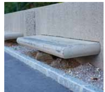
Skater haben eine Bank an der Hochwasserschutzmauer schwer beschädigt.
