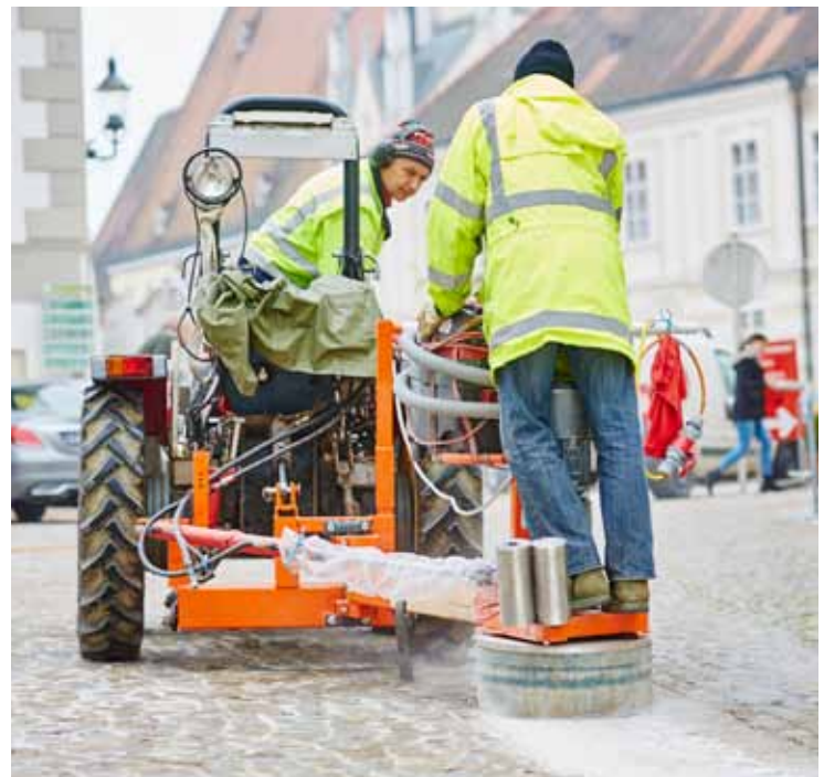
Stadtrat Anton Linsberger (am Traktor) und Mitarbeiter des Wirtschaftshofes bearbeiten die Oberfläche des Pflasters am Hauptplatz, in der Kremser Straße und bei den Schanigärten. Foto: Stadt Melk / Gleiß
