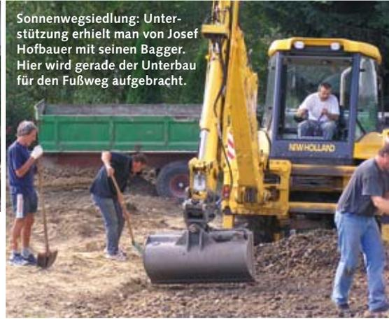
Sonnenwegsiedlung: Unterstützung erhielt man von Josef Hofbauer mit seinem Bagger. Hier wird gerade der Unterbau für den Fußweg aufgebracht.
