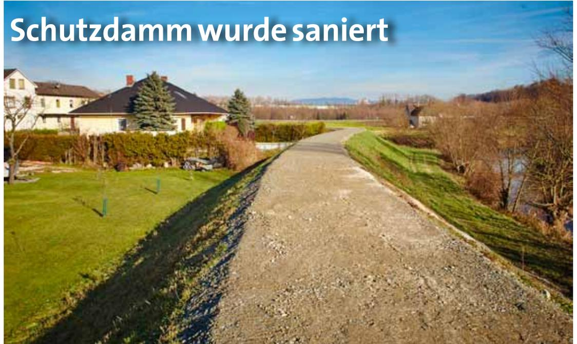
Das Jahrhunderthochwasser im Juni 2013 hat dem Hochwasserschutzdamm in Neuwinden schwer zugesetzt. Im Herbst des Vorjahres wurde der Damm saniert. Die gesamte Dammkrone wurde auf einer Länge von 150 Metern erneuert. Zusätzlich hat die Firma Siebenhandl den Damm mit Betoneinbauten verstärkt. Planung und Aufsicht des Projekts hatte die Firma Schneider Consult. Insgesamt kostete die Sanierung 50.000 Euro. *Foto: Stadt Melk / Gleiß*
